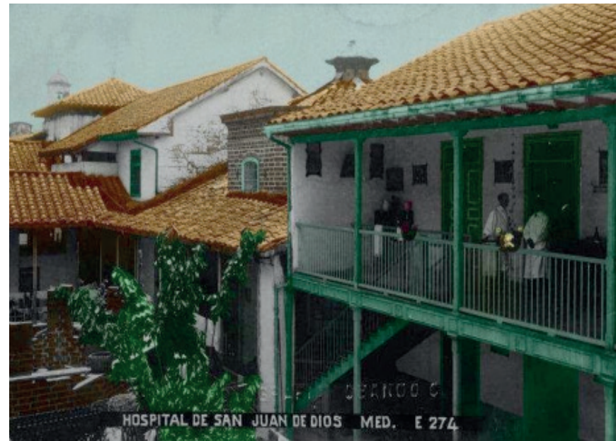
Hospital San Juan de Dios. Medellín. Fotografía de Melitón Rodríguez. Circa 1902. Abajo, a la izquierda, se observan los cimientos de la Sala de Cirugía.
