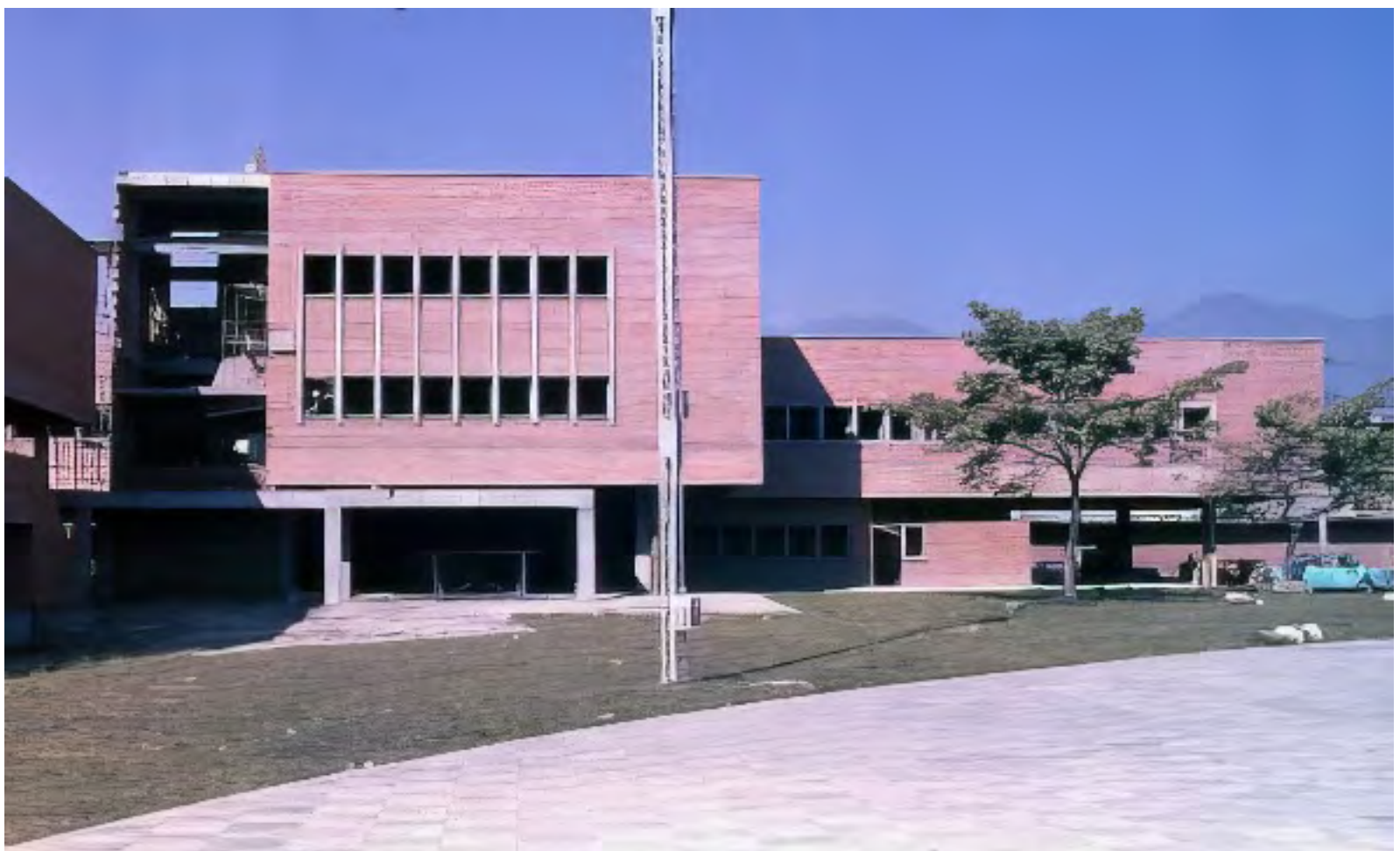
FIGURA 1. Construcción de la Casa del Deporte “Jaques de Bedout Villa”, 1978. Archivo personal.
